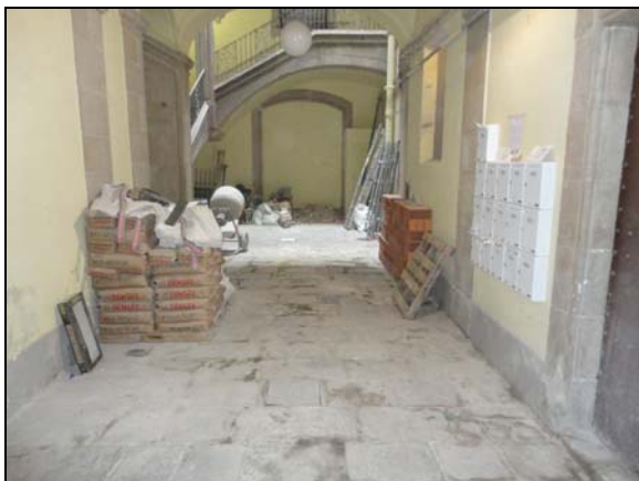
Vista des del nord-oest de l'empedrat del pati interior de la planta baixa, amb la coberta de claveguera u.e. 201.
