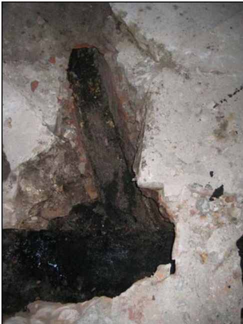
Vista des del nord-est de la claveguera u.e. 210, una vegada reorientada a l'extrem sud-est de la rasa 200.
