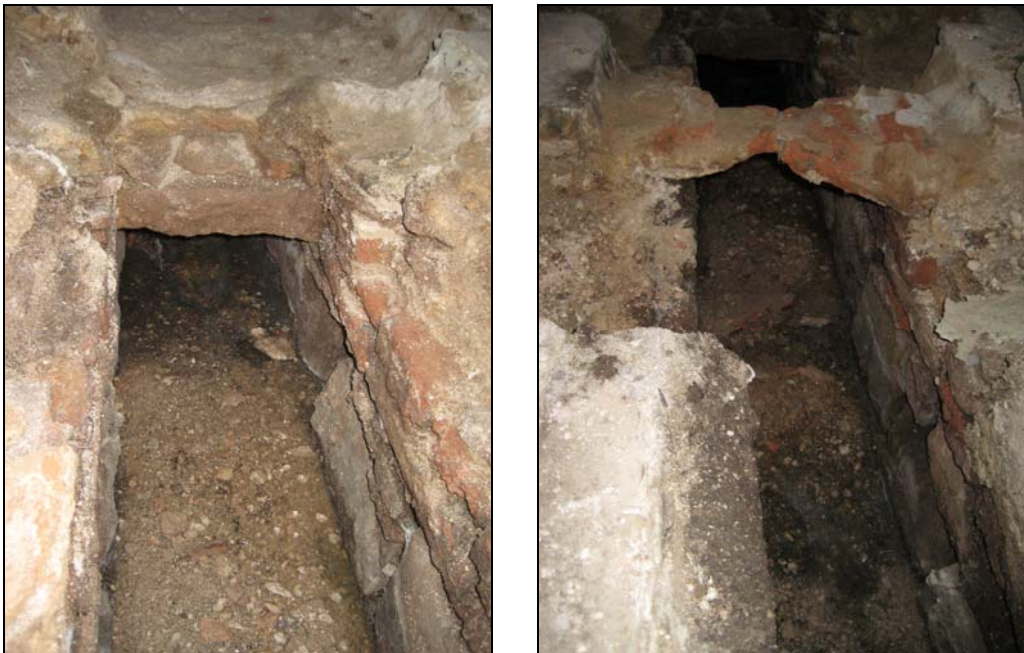
Vista des del nord-est de les diferents cobertes de la claveguera de la rasa 200, la de maons u.e. 204 i pedres u.e. 205 primer, i la volta de maons u.e. 206 després.
